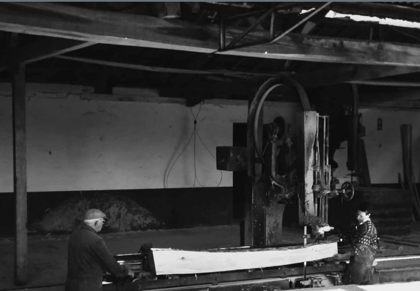
Charriot para corte dos troncos de madeira, usado na Florestal nos primeiros anos de atividade (década de 1960)
